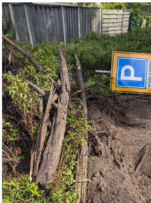
Afbeelding 16: wortelschade bij boom 21 bij plaatsing transformatorstation
