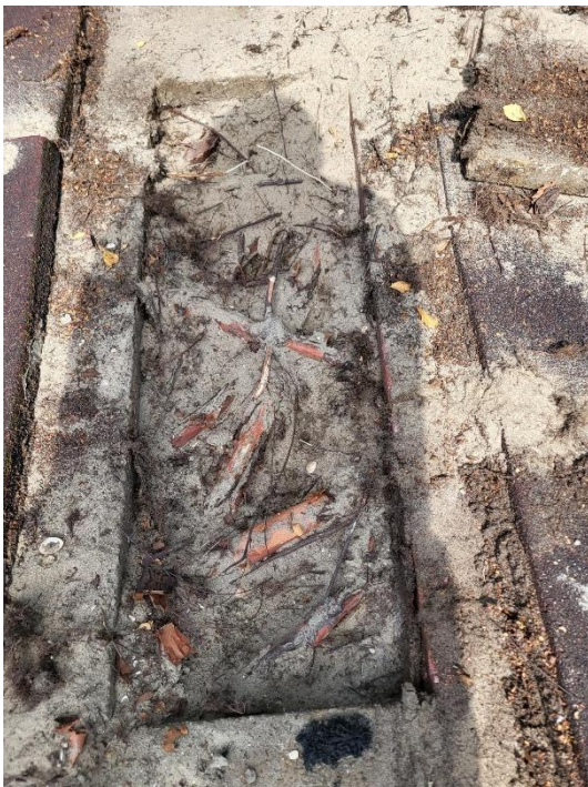
Afbeelding 12: beworteling onder bestrating
