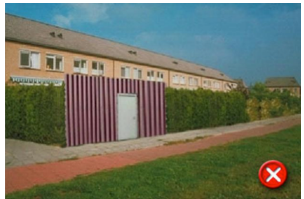
Niet passend door gebruik van damwandprofiel
