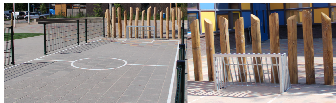
4. voorbeeld belijning op de grond, achter de doelen worden de stammen geplaatst als ballenvanger. Aan één zijkant wordt een laag dubbelstaafmathekwerk geplaatst.
